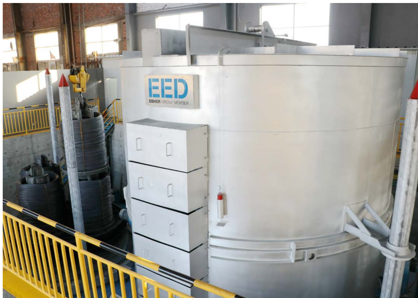
Haubenofenanlage bei Nanjing Nangang Shenghua
