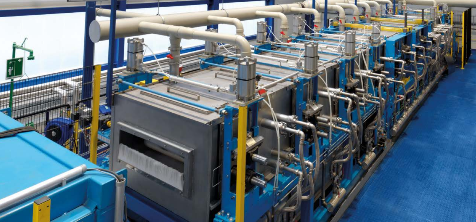
EBNER Bandreinigungseinrichtung mit Übergang von den Spülzonen zum Trockner
