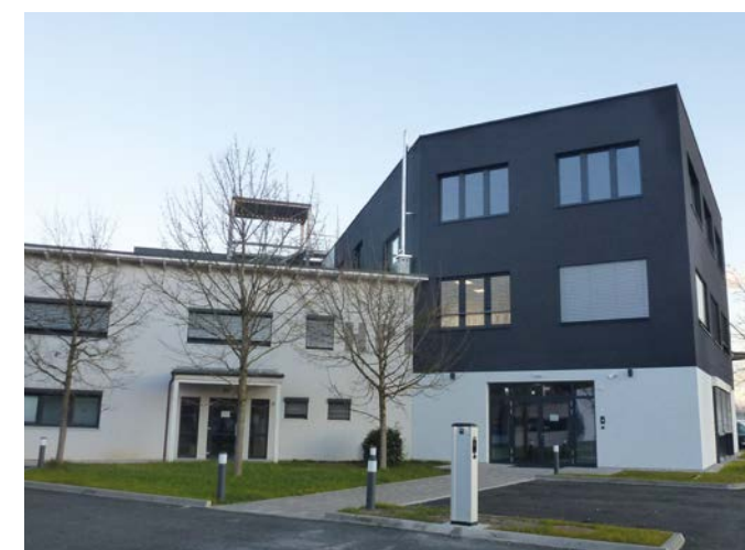
neues HPI Bürogebäude in Ranshofen, Österreich
