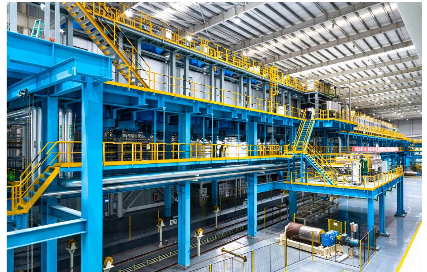
Bandschwebeanlage: Ansicht von der Quench in Richtung Ofen
