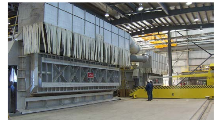
Ein Schmelzofen mit einer Kapazität von 18 t/h
