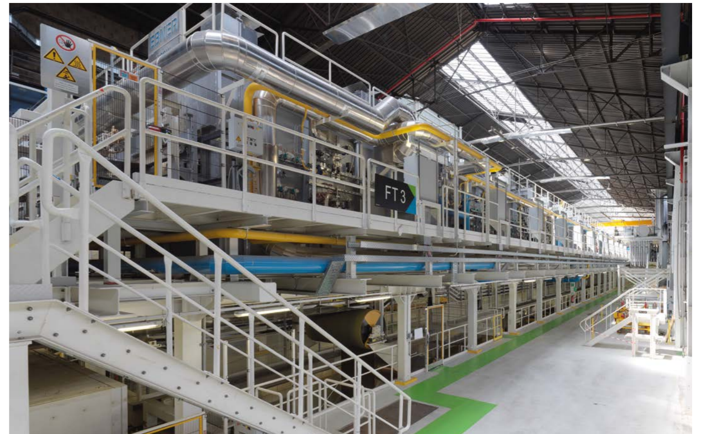
Novelis Schwebebandofenanlage in Oswego, USA; Ansicht von der Quench in Richtung Ofen
