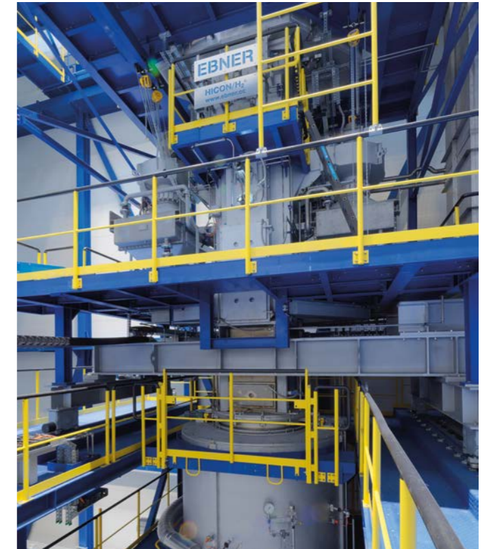
Übergang vom Hochtemperatur-Glühofen Nr. 2 zur HICON/H 2 Jetkühlzone
