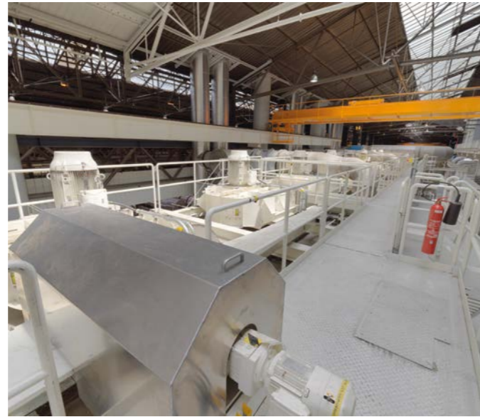
Deckenansicht der Quench mit den Gebläsen für die Umwälzung der Kühlluft in der Quench
