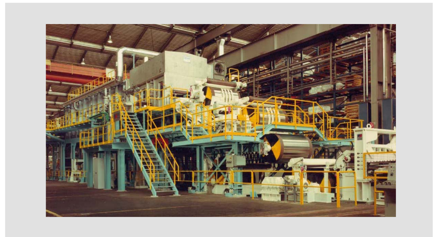
Die erste EBNER Bandschwebeanlage bei AMAG
