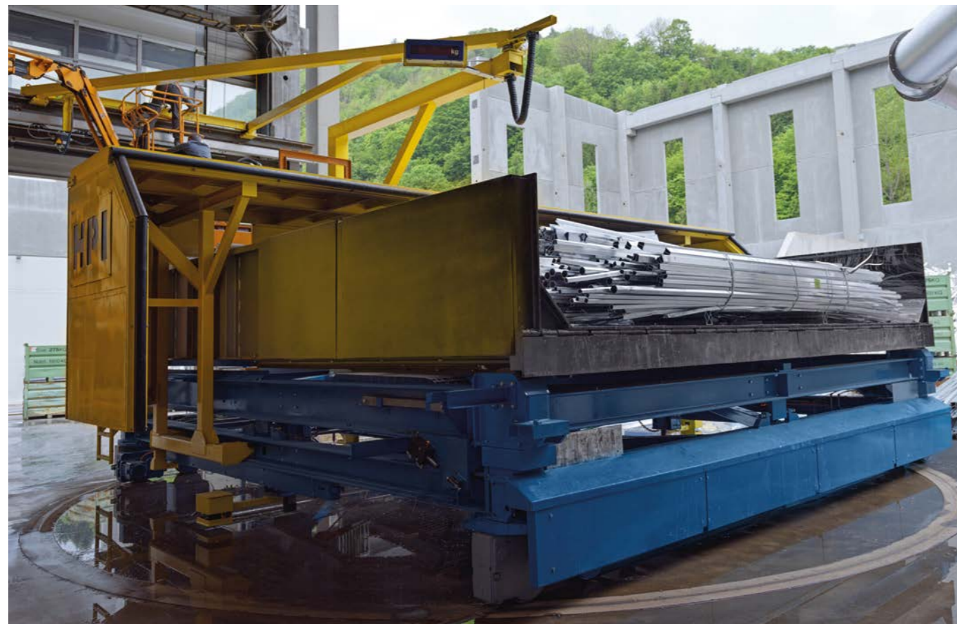
Chargiermaschine beladen mit Langschrott
