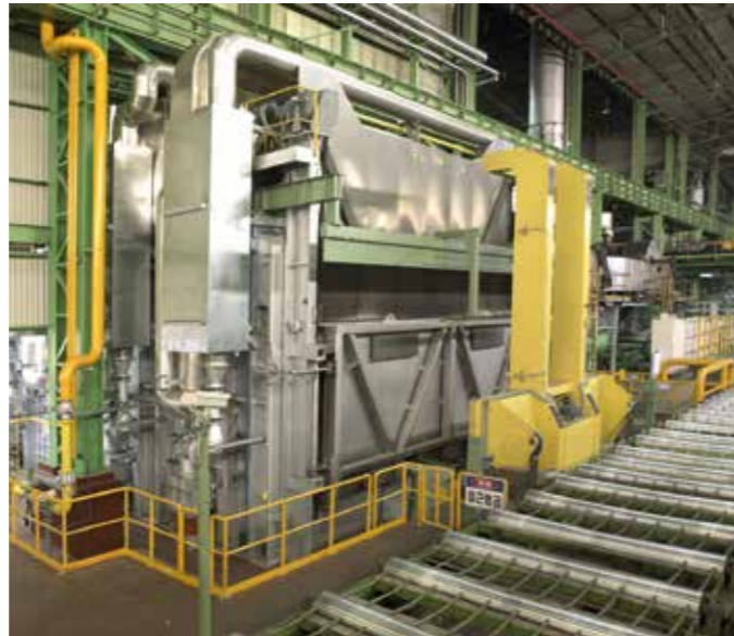
Stoßföfenanlage bei Novelis Taihan Aluminium in Korea; Ansicht Ausgangsseite
