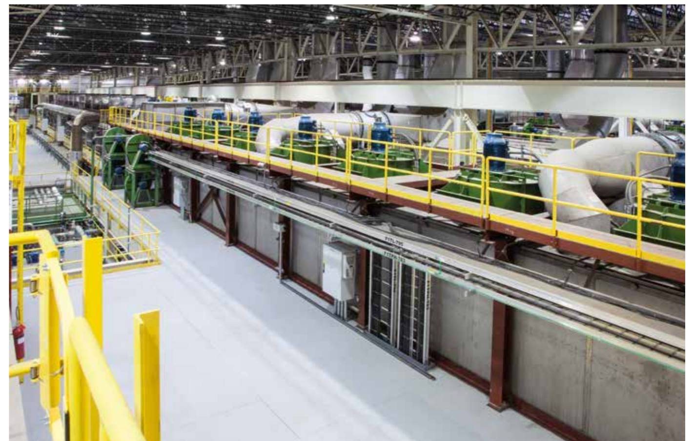
Novelis Schwebbandofenlage in Oswego, USA; Ansicht von der Quench in Richtung Ofen
