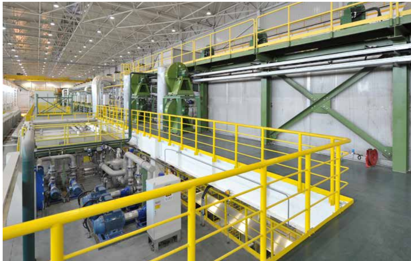
Schwebebandföfenanlage bei Novelis in China; Ansicht von der Quench in Richtung Ofen
