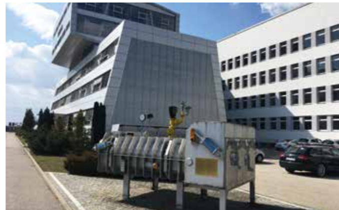
ausgestellte Vakuumschleuse bei EBNER Leonding
