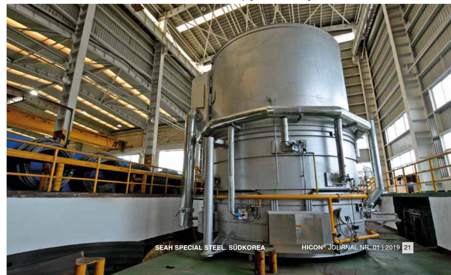
Der jüngste Ausbau in Nantong – Heizhaube mit ca. 6.5 m Durchmesser
