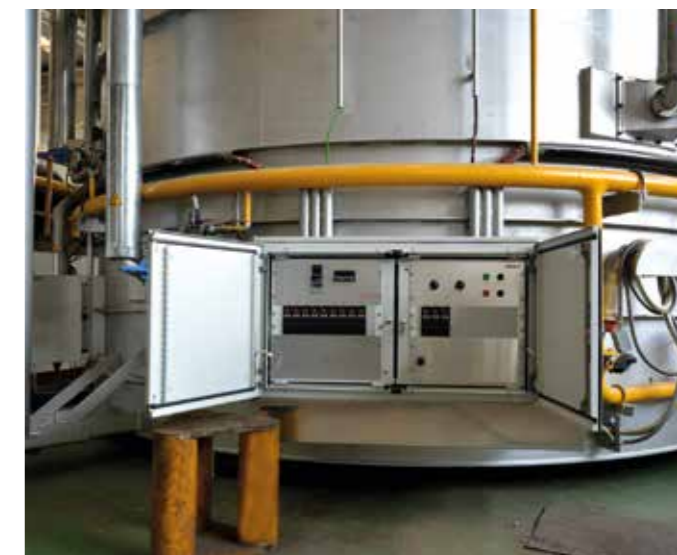
Auch die Schaltschränke werden von EBNER geliefert
