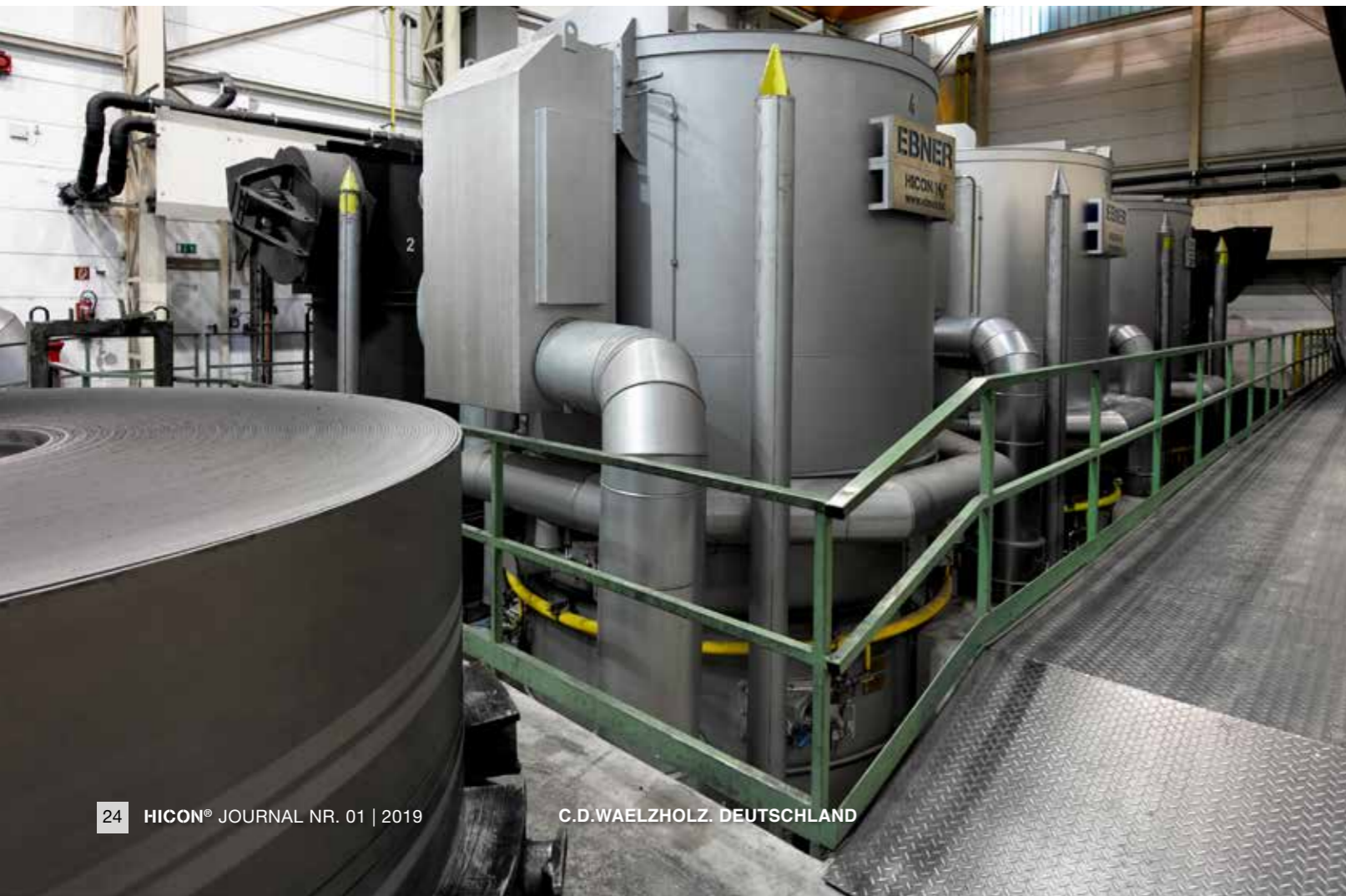
EBNER HICON/H 2 Haubenofenanlage CD Waelzholz Werk in Plettenberg
